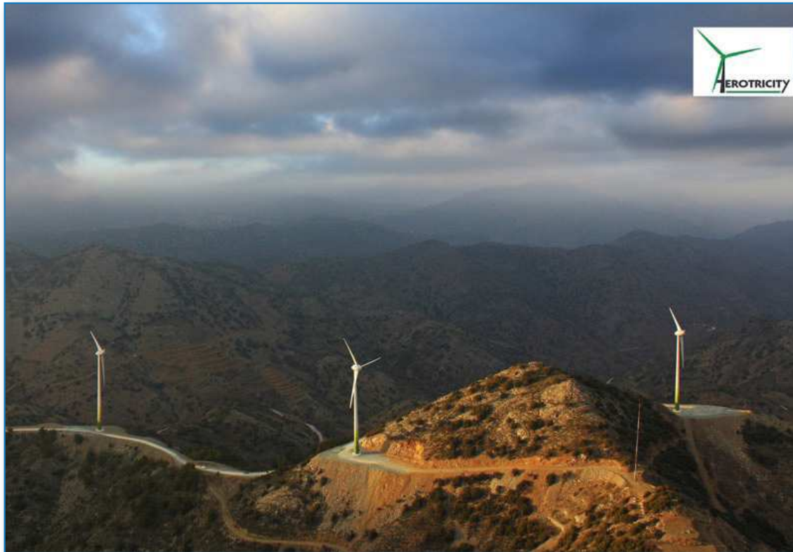
Το αιολικό πάρκο σε Αγία Άννα και Καμπί. Πηγή: Aerotricity Ltd Εγκατεστημένης Ισχύος 2.4MW
